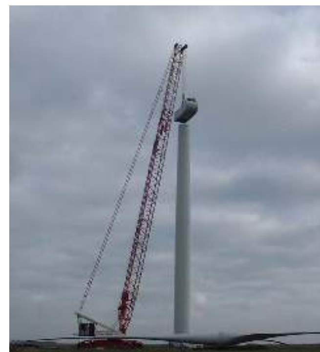
Montage de la nacelle
