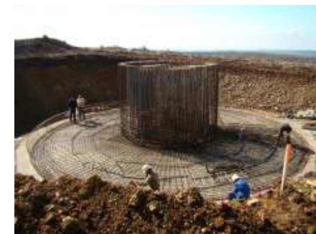
Photo 6 : Armature (Photo : VALOREM)
