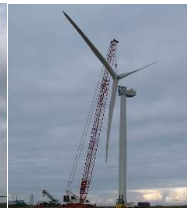
Montage du rotor
