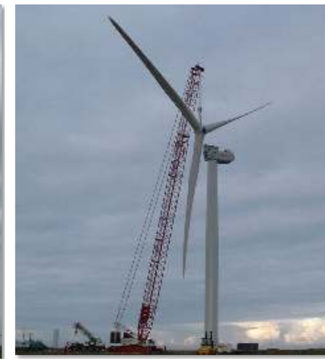
Photo 13 : Mise en place du rotor tripale (Photo : VALOREM)
