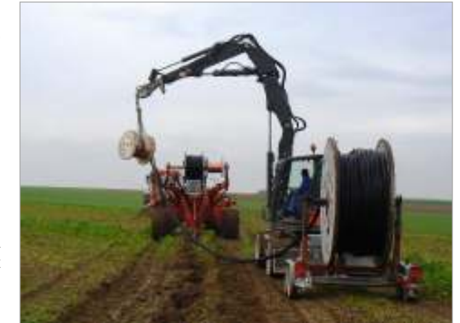
Photo 14 : Pose d'un câble HTA à 1,20 m avec la méthode du soc tracté (source VALOREM)
