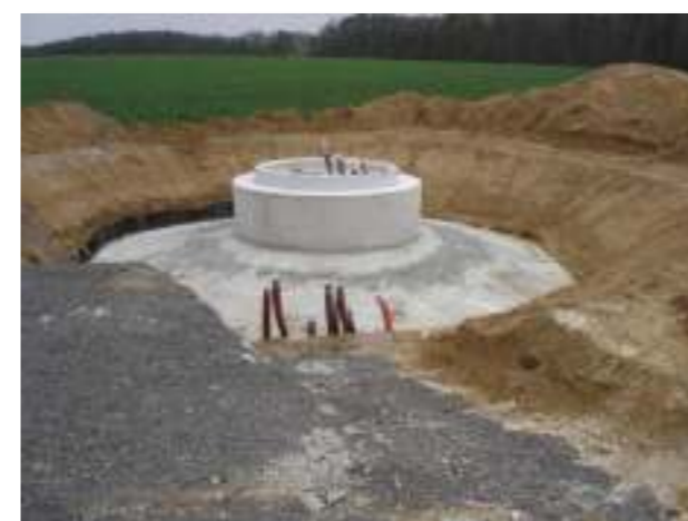
Photo 7 : Béton terminé (Photo : VALOREM)
