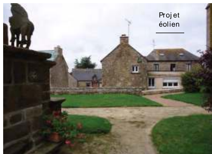
MH 7 - Calvaire de Senven-Léhart : protégé des vues vers le projet éolien par le bâti dense enserrant la Place de l'Eglise.
