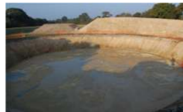
Photo 5 : Excavation (Photo : VALOREM)
