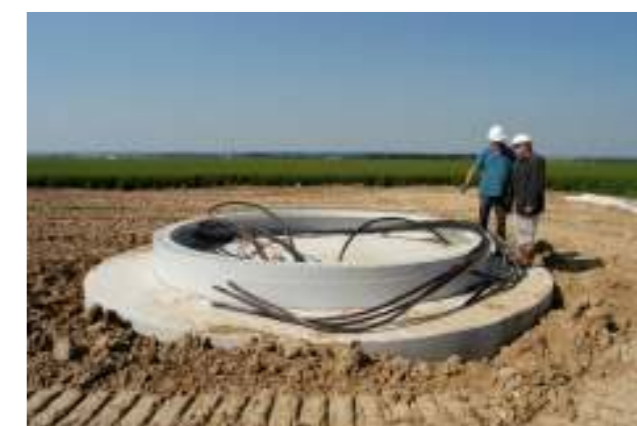
Photo 8 : Fondation terminée (Photo : VALOREM)
