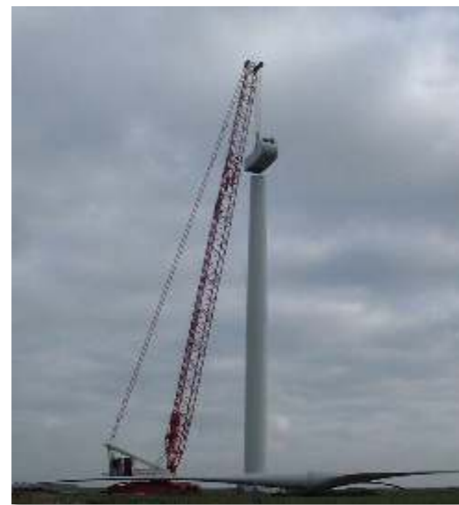
Photo 12 : Installation de la nacelle (Photo : VALOREM)
